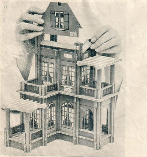
7. — Après terminaison du 1<sup>er</sup> étage, disposer les Tenons A et A bis du 2<sup>e</sup> étage, placer les Piliers B.3, puis introduire les Compensateurs C.6 et C.6 ter, ainsi que les Pignons F.2.
